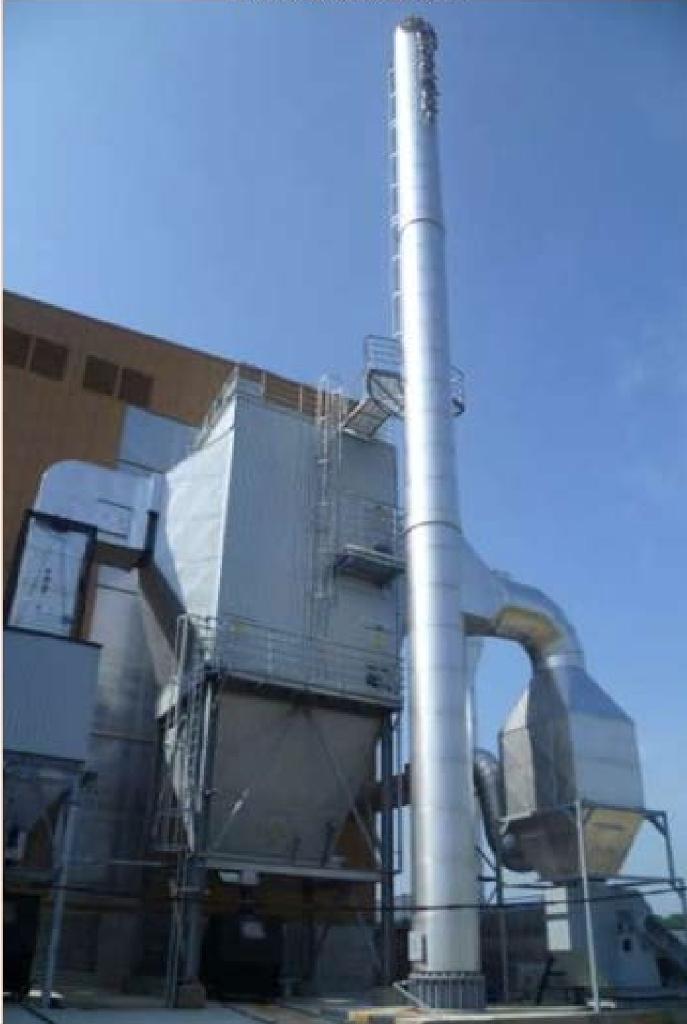
Toranj sa dimnjakom
