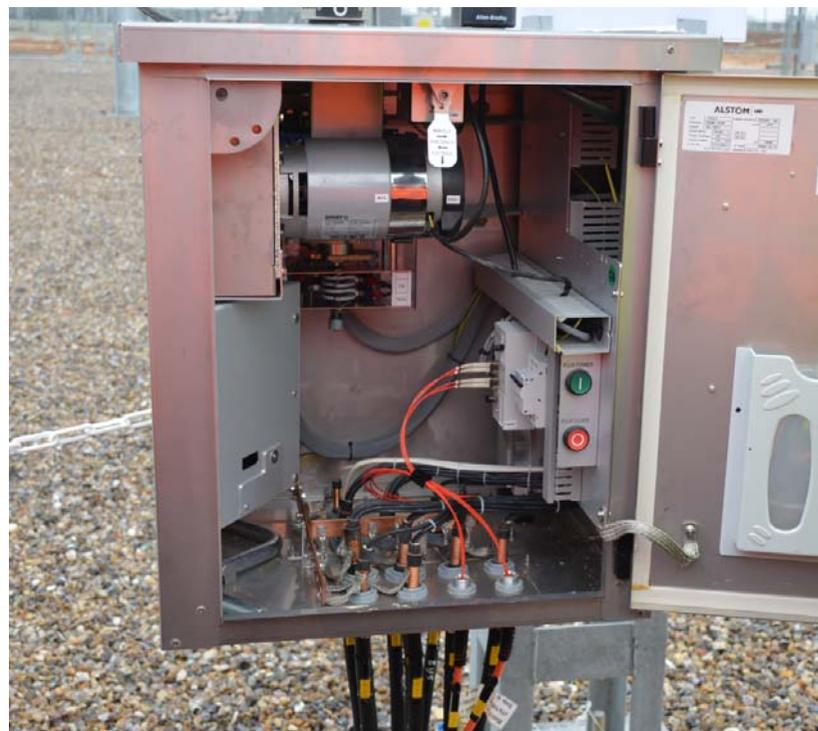
Привод разъединителя Alstom со встроенной функцией диагностики (включая контроль нагрузки (вращающего момента) на валу двигателя )
