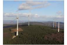
Ellern, Stetten 86 MW 21 WTG
